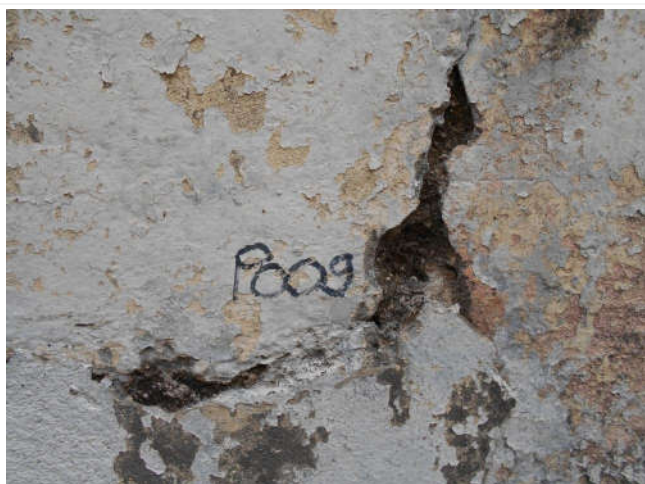
Composant : Peinture ou enduit 9 (N) P009 - Enduit ou peinture couleur blanche et sous couche beige et grise Enduit ou peinture localisés sur les murs de façades extérieures de la Maison d'Arrêt au point P009 (voir le plan de repérage)
