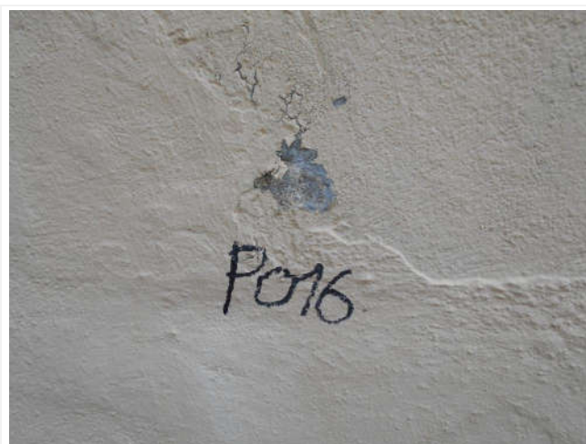
Composant : Peinture ou enduit 16 (N) P016 - Enduit ou peinture couleur coquille d'œuf et sous couche grise Enduit ou peinture localisés sur les murs de façades extérieures de la Maison d'Arrêt au point P016 (voir le plan de repérage)
