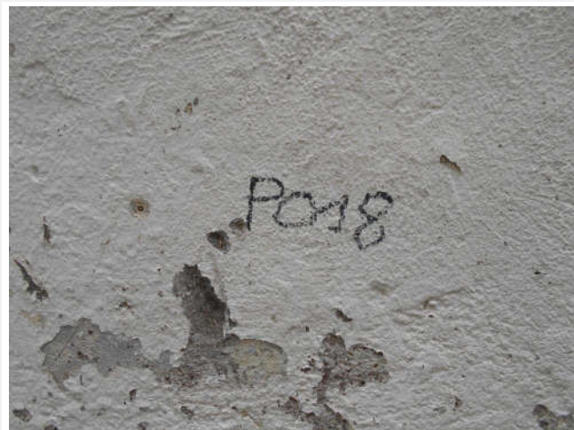
Composant : Peinture ou enduit 18 (N) P018 - Enduit ou peinture couleur blanche et sous couche grise Enduit ou peinture localisés sur les murs de façades extérieures de la Maison d'Arrêt au point P018 (voir le plan de repérage)
