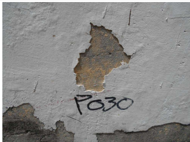
Composant : Peinture ou enduit 30 (N) P030 - Enduit ou peinture couleur blanche et sous couche beige et grise Enduit ou peinture localisés sur les murs de façades extérieures de la Maison d'Arrêt au point P030 (voir le plan de repérage)
