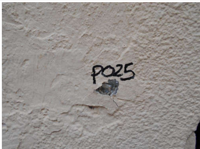
Composant : Peinture ou enduit 25 (a) P025 - Enduit ou peinture couleur coquille d'œuf et sous couche blanche et grise Enduit ou peinture localisés sur les murs de façades extérieures de la Maison d'Arrêt au point P025 (voir le plan de repérage)
