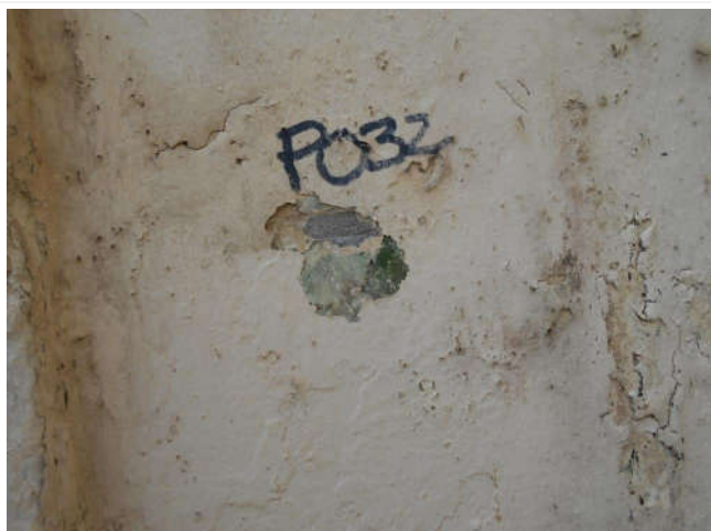
Composant : Peinture ou enduit 32 (N) P032 - Enduit ou peinture couleur coquille d'œuf et sous couche grise Enduit ou peinture localisés sur les murs de façades extérieures des logements de fonction au point P032 (voir le plan de repérage)
