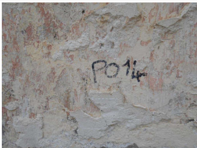
Composant : Colles des carrelages 14 (a) P014 - Colle de faïence sur murs couleur gris clair Colle de faïence localisée sur les murs de façades extérieures de la Maison d'Arrêt au point P014 (voir le plan de repérage)
