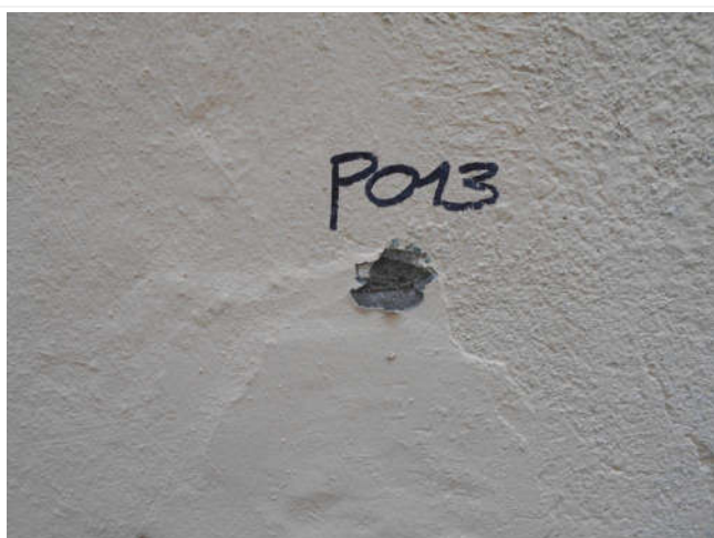
Composant : Peinture ou enduit 13 (N) P013 - Enduit ou peinture couleur coquille d'œuf et sous couche grise Enduit ou peinture localisés sur les murs de façades extérieures de la Maison d'Arrêt au point P013 (voir le plan de repérage)
