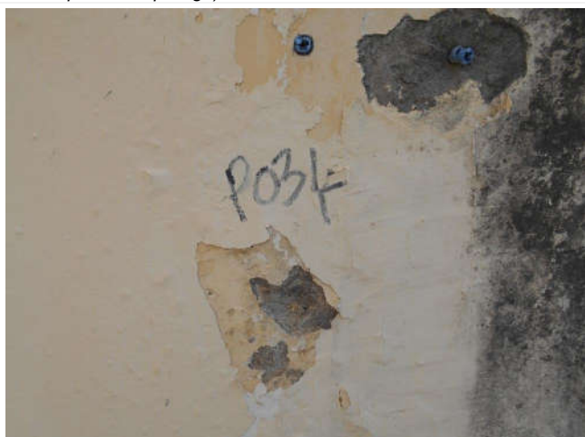
Composant : Peinture ou enduit 34 (a) P034 - Enduit ou peinture couleur coquille d'œuf et sous couche beige et grise Enduit ou peinture localisés sur les murs de façades extérieures des logements de fonction au point P034 (voir le plan de repérage)
