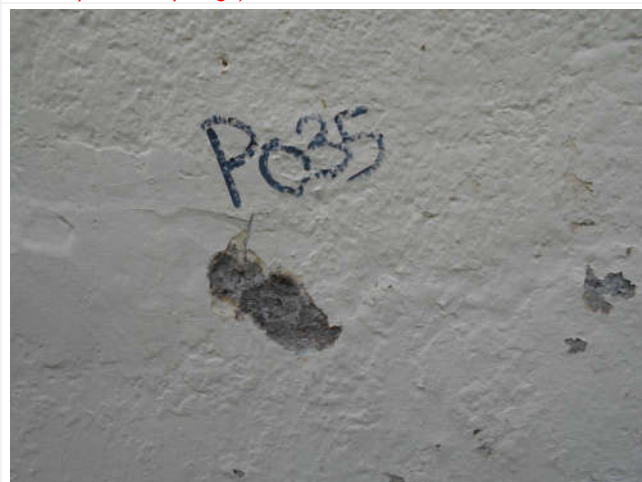
Composant : Peinture ou enduit 35 (a) P035 - Enduit ou peinture couleur coquille d'œuf et sous couche grise Enduit ou peinture localisés sur les murs de façades extérieures des logements de fonction au point P035 (voir le plan de repérage)
