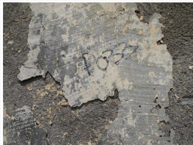
Composant : Peinture ou enduit 33 (a) P033 - Enduit ou peinture couleur coquille d'œuf et sous couche grise Enduit ou peinture localisés sur les murs de façades extérieures des logements de fonction au point P033 (voir le plan de repérage)
