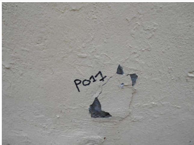
Composant : Peinture ou enduit 11 (N) P011 - Enduit ou peinture couleur coquille d'œuf et sous couche grise Enduit ou peinture localisés sur les murs de façades extérieures de la Maison d'Arrêt au point P011 (voir le plan de repérage)
