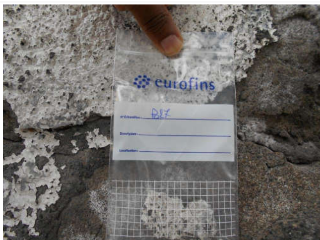
Composant : Peinture ou enduit 27 (N) P027 - Enduit ou peinture couleur blanche et sous couche grise Enduit ou peinture localisés sur les murs de façades extérieures de la Maison d'Arrêt au point P027 (voir le plan de repérage)
