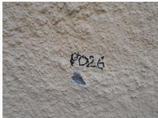
Composant : Peinture ou enduit 26 (N) P026 - Enduit ou peinture couleur coquille d'œuf et sous couche blanche et grise Enduit ou peinture localisés sur les murs de façades extérieures de la Maison d'Arrêt au point P026 (voir le plan de repérage)
