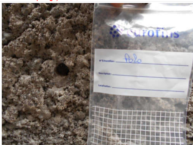
Composant : Enduits projetés 20 (N) P020 - Enduit projeté couleur gris foncé Enduit projeté localisé sur les murs de façades extérieures de la Maison d'Arrêt au point P020 (voir le plan de repérage)
