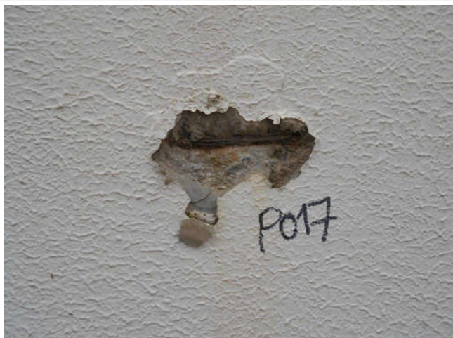
Composant : Peinture ou enduit 17 (N) P017 - Enduit ou peinture couleur blanche et sous couche grise Enduit ou peinture localisés sur les murs de façades extérieures de la Maison d'Arrêt au point P017 (voir le plan de repérage)
