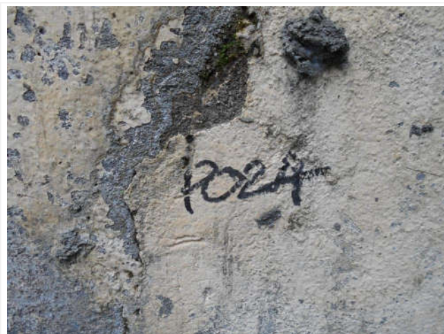
Composant : Peinture ou enduit 24 (N) P024 - Enduit ou peinture couleur beige et sous couche grise Enduit ou peinture localisés sur les murs de façades extérieures de la Maison d'Arrêt au point P024 (voir le plan de repérage)
