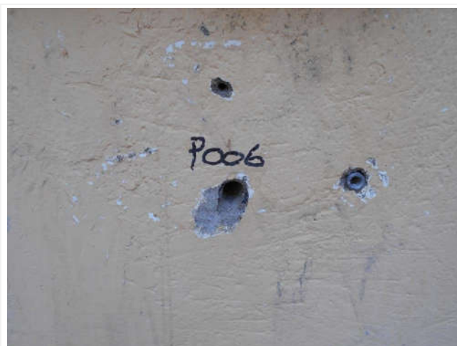
Composant : Peinture ou enduit 6 (N) P006 - Enduit ou peinture couleur coquille d'œuf et sous couche blanche et grise Enduit ou peinture localisés sur les murs de façades extérieures de la Maison d'Arrêt au point P006 (voir le plan de repérage)
