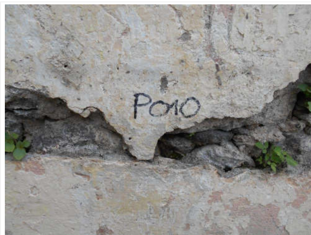
Composant : Peinture ou enduit 10 (N) P010 - Enduit ou peinture couleur blanche et sous couche beige et grise Enduit ou peinture localisés sur les murs de façades extérieures de la Maison d'Arrêt au point P010 (voir le plan de repérage)
