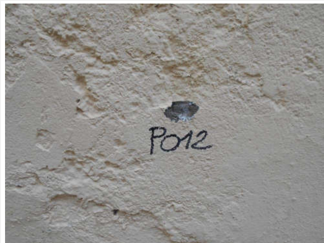
Composant : Peinture ou enduit 12 (N) P012 - Enduit ou peinture couleur coquille d'œuf et sous couche blanche et grise Enduit ou peinture localisés sur les murs de façades extérieures de la Maison d'Arrêt au point P012 (voir le plan de repérage)
