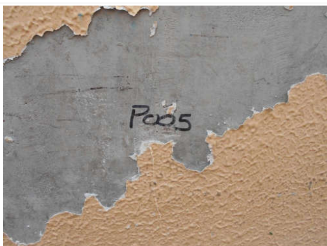
Composant : Peinture ou enduit 5 (N) P005 - Enduit ou peinture couleur coquille d'œuf et sous couche blanche et grise Enduit ou peinture localisés sur les murs de façades extérieures de la Maison d'Arrêt au point P005 (voir le plan de repérage)
