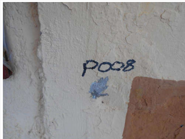
Composant : Peinture ou enduit 8 (N) P008 - Enduit ou peinture couleur coquille d'œuf et sous couche grise Enduit ou peinture localisés sur les murs de façades extérieures de la Maison d'Arrêt au point P008 (voir le plan de repérage)
