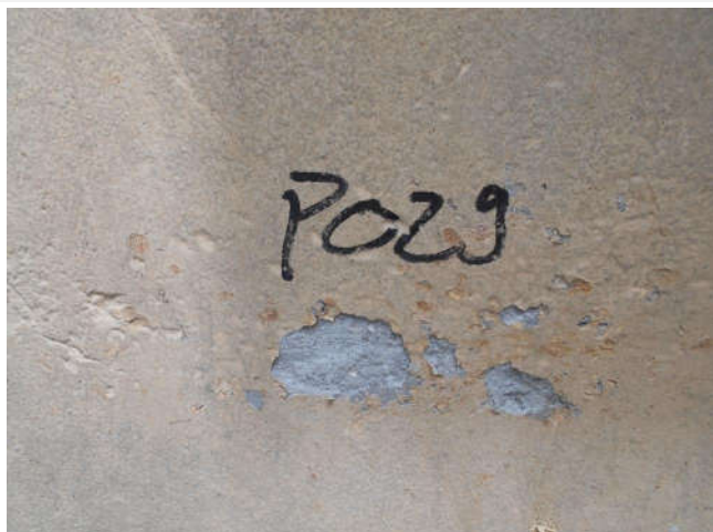
Composant : Peinture ou enduit 29 (N) P029 - Enduit ou peinture couleur coquille d'œuf et sous couche grise Enduit ou peinture localisés sur les murs de façades extérieures de la Maison d'Arrêt au point P029 (voir le plan de repérage)
