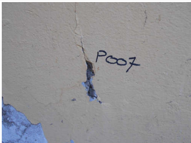
Composant : Peinture ou enduit 7 (N) P007 - Enduit ou peinture couleur coquille d'œuf et sous couche grise Enduit ou peinture localisés sur les murs de façades extérieures de la Maison d'Arrêt au point P007 (voir le plan de repérage)
